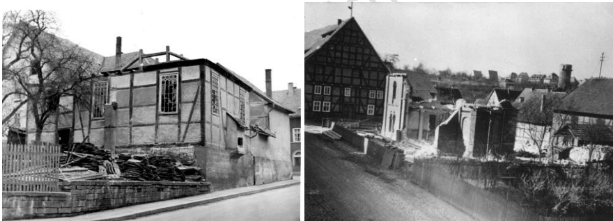
Abbruch der Synagogengebäude in Hofgeismar 1939 (l.) und Grebenstein (r.)
