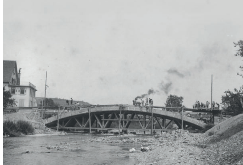
Beim Bau der Filsbrücke 1901
